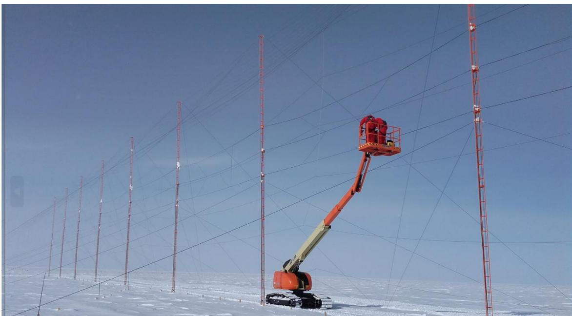
*1 SuperDARN – il radar a bassa frequenza installato presso la Stazione Concordia*
